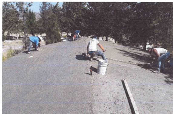
LOSA PLANA EN ESTRUCTURA, PERALTE =10CMS CIMBRA COMUN REFORZADA CON 60KG DE ACERO POR M3, CONCRETO 30401 F'C=200KG/CM2-3/4"
