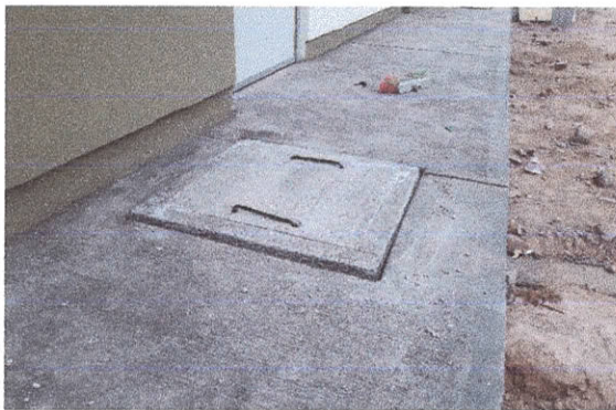
42410 REGISTRO DE 0.60 X 0.60 X 0.80 M (INT) DE TABIQUE RECOCIDO EN 13 CM JUNTEADO CON MORTERO CEMENTO ARENA 1:4 ACABADO PULIDO PLANTILLA DE CONCRETO F'C= 150KG/CM2
