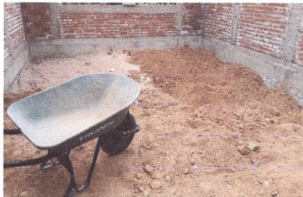
TEM10 RELLENO Y COMPACTADO DE TERRENO PARA BASE DE PISO DE CONCRETO CON TIERRA NATURAL
