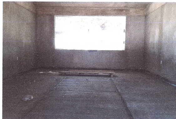
TEMP8 PISO DE CONCRETO SIMPLE DE 10 CMS DE ESPESOR CONCRETO HECHO EN OBRA F'C= 150 KG/CM2 AGREGADO MAXIMO DE 1 1/2" ACABADO ESCOBILLADO
