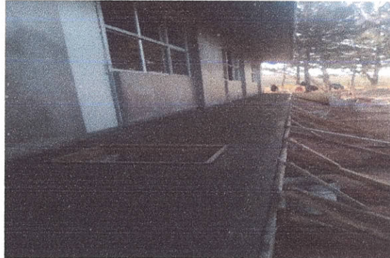
42410 REGISTRO DE 0.60 X 0.60 X 0.80 M (INT) DE TABIQUE RECOCIDO EN 13 CM JUNTEADO CON MORTERO CEMENTO ARENA 1:4 ACABADO PULIDO PLANTILLA DE CONCRETO F'C= 150KG/CM2
