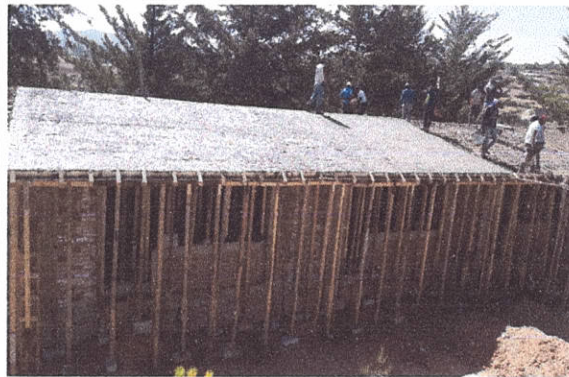
LOSA PLANA EN ESTRUCTURA, PERALTE =10CMS CIMBRA COMUN REFORZADA CON 60KG DE ACERO POR M3, CONCRETO 30401 F'C=200KG/CM2-3/4"
