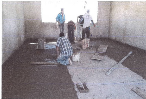
TEMP8 PISO DE CONCRETO SIMPLE DE 10 CMS DE ESPESOR CONCRETO HECHO EN OBRA F'C= 150 KG/CM2 AGREGADO MAXIMO DE 1 1/2" ACABADO ESCOBILLADO
