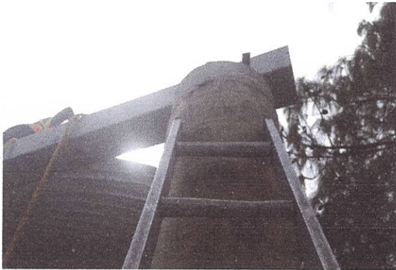
EST-CAN-001 SUMINISTRO, FABRICACION Y COLOCACION DE CANALON DE DESAGUE A BASE DE LAMINA GALVANIZADA CAL. 11, INCLUYE: SOLDADURA.
